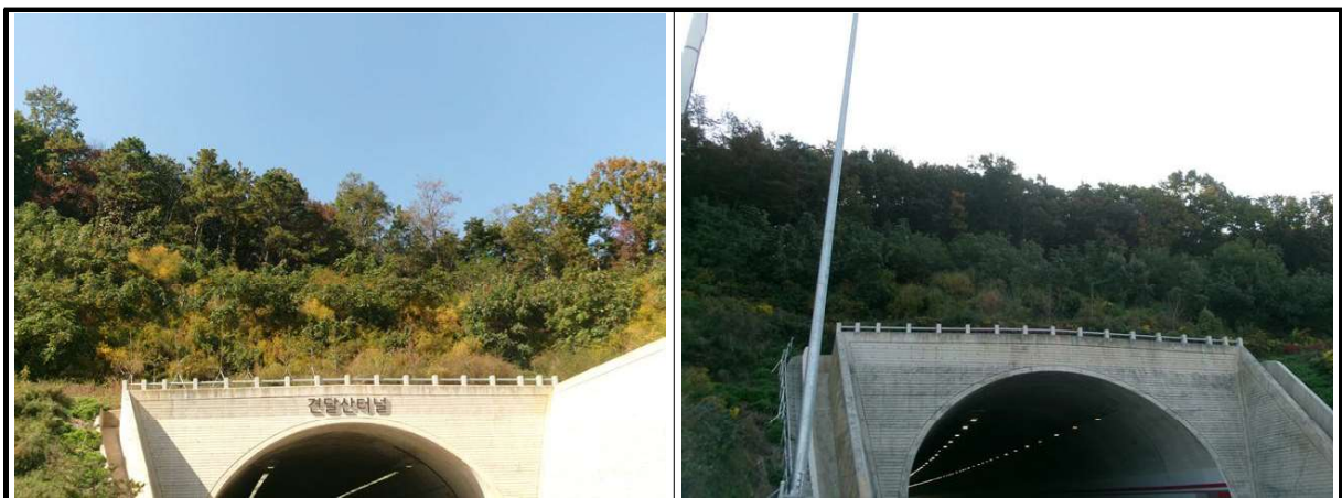
【사진 3.3.20】 사면 전경
