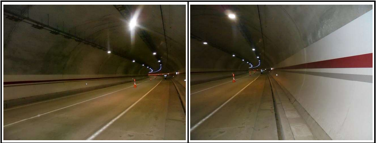
【사진 3.3.16】 라이닝 측벽부 전경
