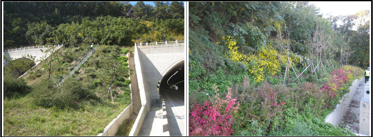
【사진 3.3.7】 사면 전경
