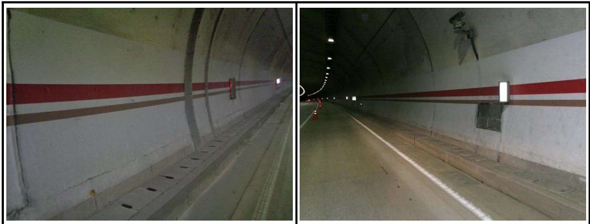
【사진 3.3.3】 라이닝 측벽부 전경
