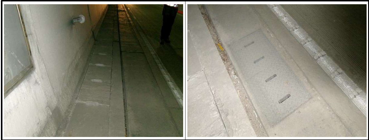
【사진 3.3.8】 공동구 및 배수시설 전경
