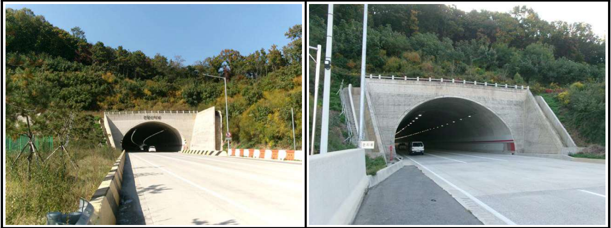
【사진 3.3.14】 라이닝 천단부 전경
