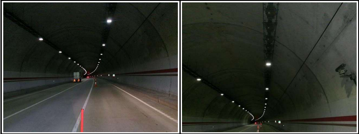
【사진 3.3.1】 라이닝 천단부 전경
