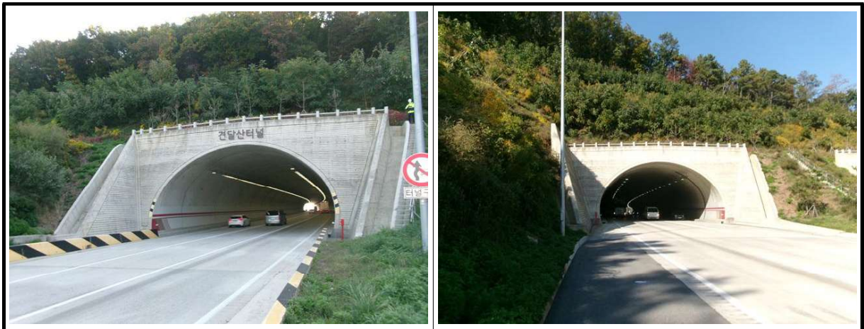
【사진 3.3.5】 갭문 전경
