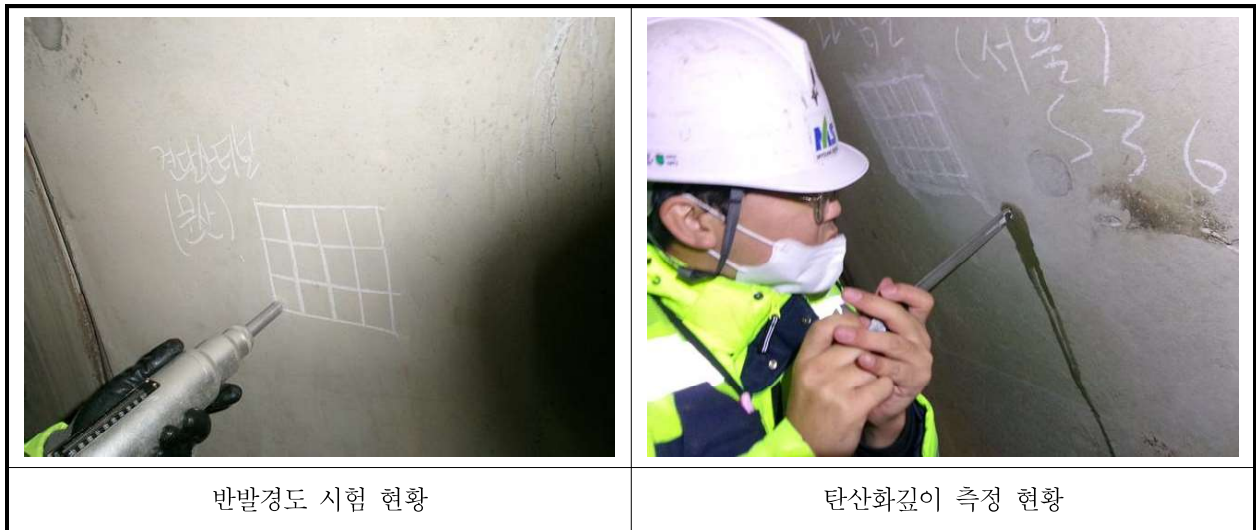
【사진 3.4.1】 콘크리트 내구성조사 현황
